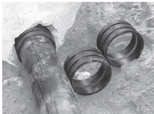
Фото 2.1. Защитные муфты для входа в бетонный колодец
