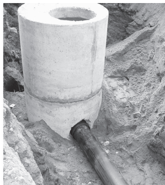
Фото 2.1. Защитные муфты для входа в бетонный колодец
