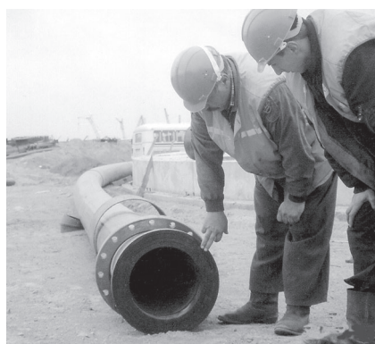
Фото 1.4. Разъемное фланцевое соединение ПЭ труб
